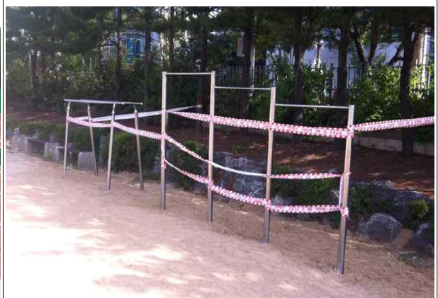
생활체육시설 설치 후
